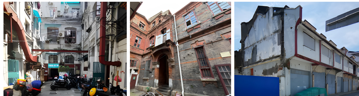
图 3：更新前保护保留建筑现状照片
